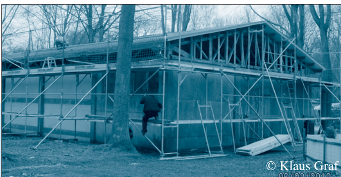
Auf dem Ostseecamp wird aus der Strandkorbhalle ein Indoorspielplatz
