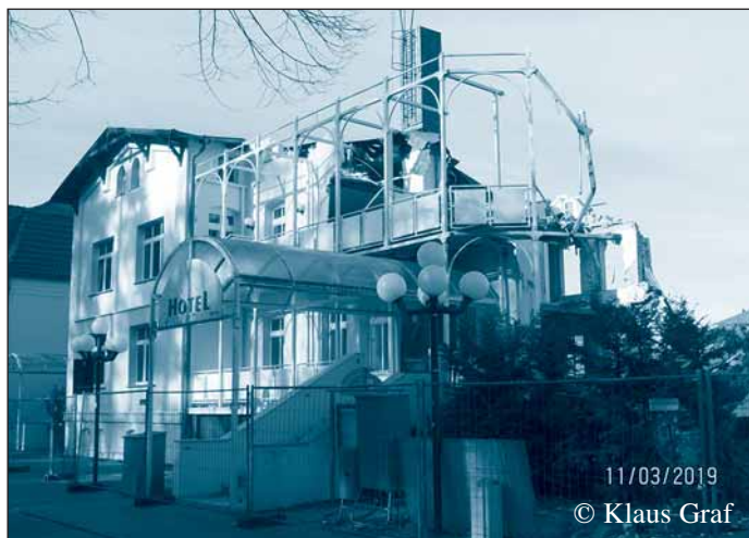
Abriss des alten Hotels Residenz
