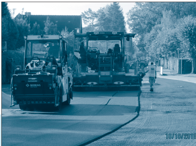
Erneuerung der Straßendecke der L 22 von Graal-Müritz bis Klockenhagen
