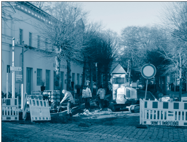
Am 12. November begann die Neugestaltung der Kurstraße.
